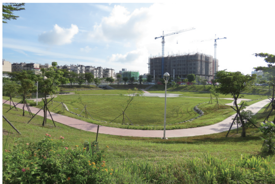
2017年曾榮獲高雄市建築園治獎的北屋滯洪池
